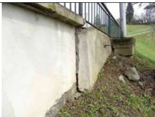
Opěrná zeď (OZ) navazující na křídlo K4P. OZ se vyklonila, byla zajištěna ocelovým táhlem
