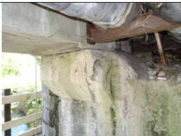
Krátká konzola podpěry P3. Održený beton krátké konzoly. Nečistoty na úložném prahu.
