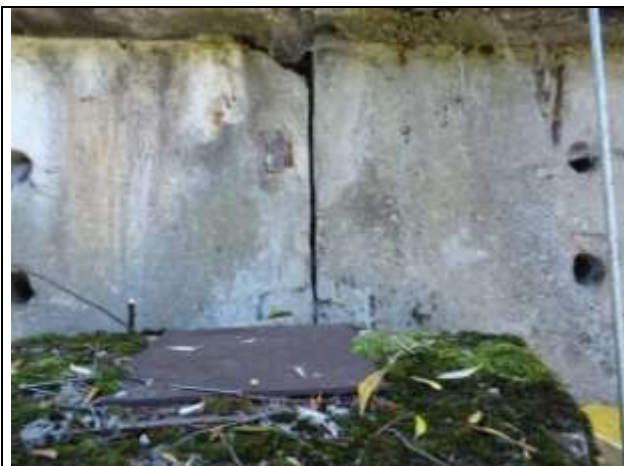
Dilatační spára 2. a 3. Pole nad podpěrou P3 – zhlaví obrostlé mechem.
