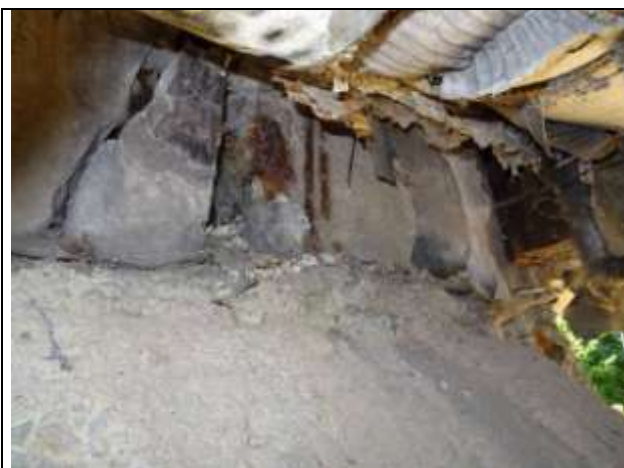
Uložení MPD nosníků na podpěře P2 na povodní straně lávky. Održená dobetonávka v kotevní oblasti nosníků. Nedostatečné krytí třmínků nosníků.
