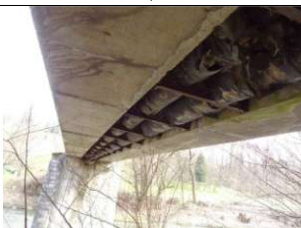
Pole 1 - podhled MPD nosníků. Stopy po zatékání mostovkou.
