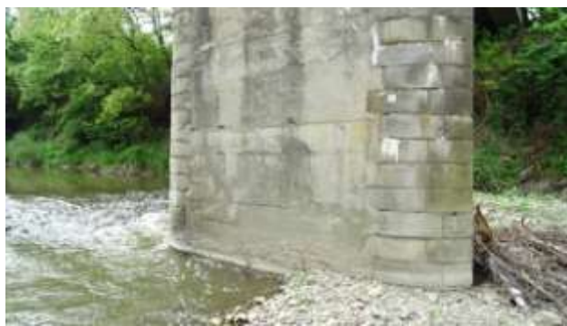
Podpěra P3 – spodní část. Průsaky ve zdivu zhlaví.
