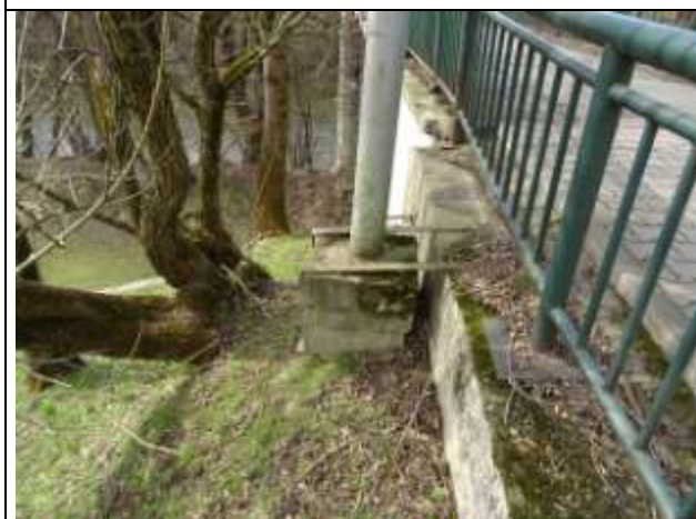
Detail betonového základu stožáru VO za OP4 vpravo. Základ se naklání, byl zajištěn ocelovými pásy
