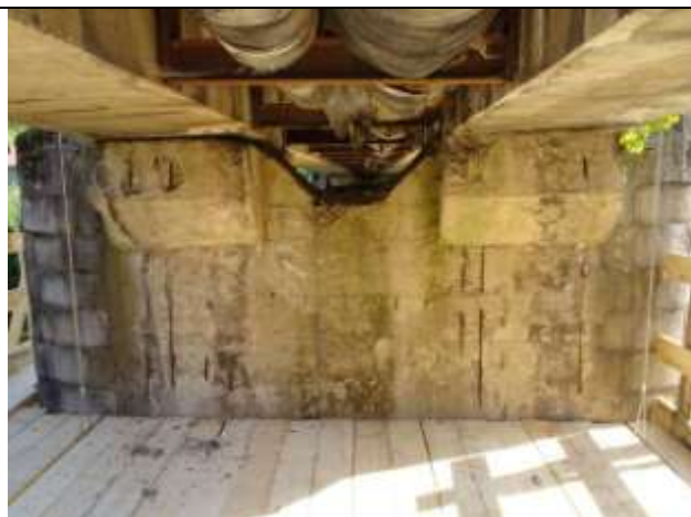
Úložný práh s krátkými konzolami podpěry P2. Nedostatečné krytí svislé výztuže pilíře. Zhlaví zanečistěno vegetací.
