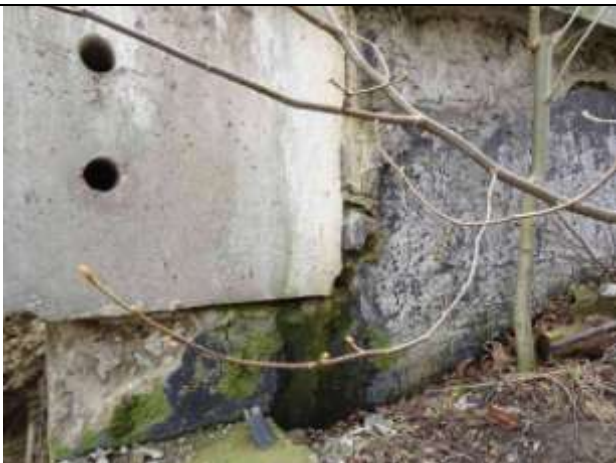
Opěra 1 – křídlo K1L. Uložení nosníků bezložiskové. Rozpadlý roh úložného prahu.
