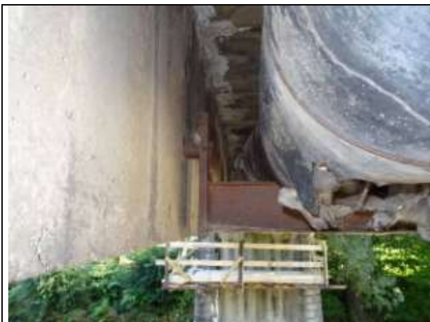
OPP- příčníky jsou zavěšeny na čepu, který je vložený do otvoru ve stěně nosníku MPD. Posun uložení.
