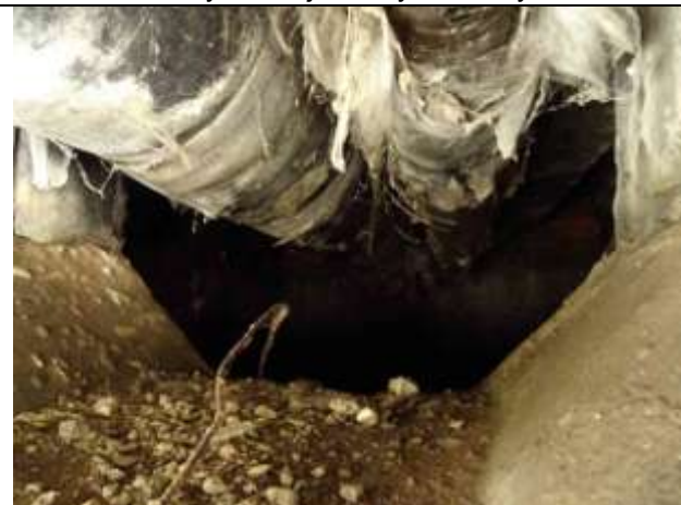
Pohled na OP1. Ve spodní části je sesutý svah před opěrou, obnažený beton je hrubý, nerovný.
