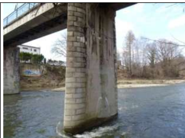
Podpěra P2. Průsaky v dřívku pilíře.
