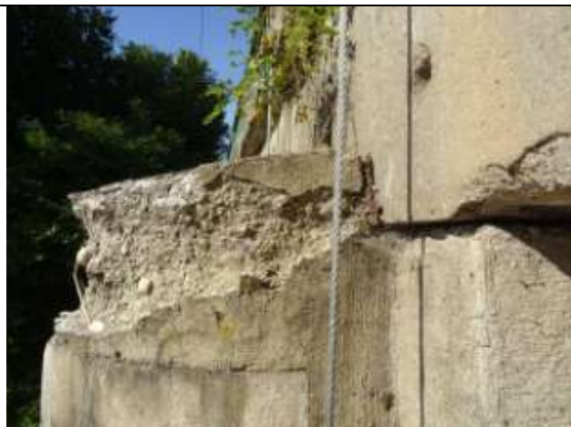
Zhlaví na návodní straně podpěry P2. Rozpad betonu zhlaví.
