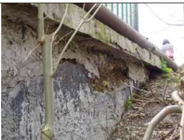
Levé křídlo opěry 1 – křídlo K1L. Nesoudržný beton, tvorba kaverny.
