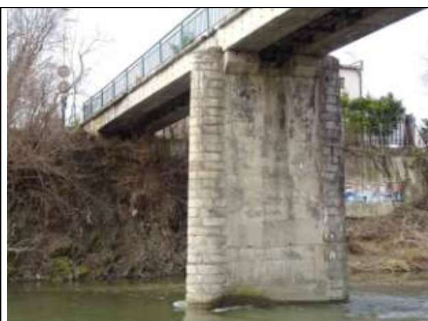
Podpěra P2. Průsaky v dřívku pilíře.
