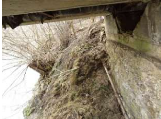
Pohled na OP1. Ve spodní části je sesutý svah před opěrou, obnažený beton je hrubý, nerovný.
