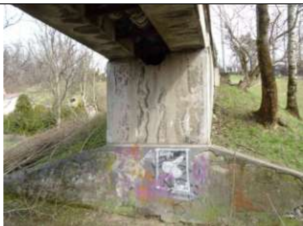
Pohled na opěru 4 se svahovým křídlem.
