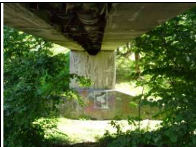
Podhled nosníků 3. pole. Stopy po zatékání s výluhy na podhledu nosníku.
