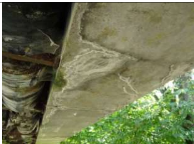
Výluhy na podhledu levého MPD nosníku v poli 2.
