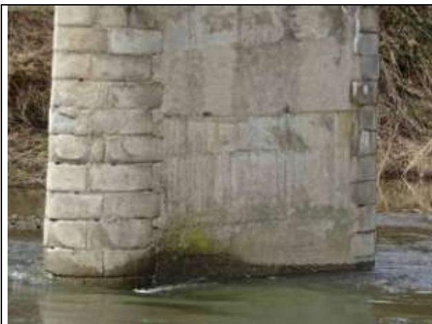
Podpěra P2 – spodní část. Průsaky ve zdivu. Rozrušené spárování kamenného obkladu.
