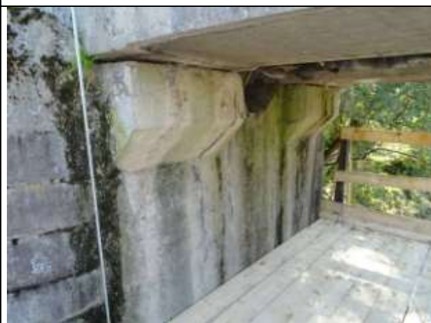
Úložný práh s krátkými konzolami podpěry P3. Povrch potečený, obrostlý mechem.
