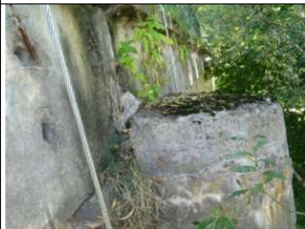
Povodní zhlaví podpěry P3. Zaneseno vegetací. Beton s trhlinami.
