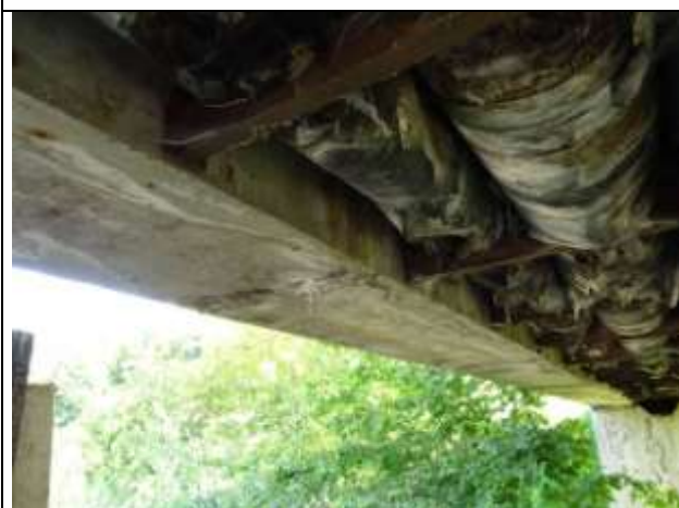
Inkrustace ve spáře na podhledu pravého MPD nosníku v poli 2.
