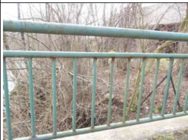
Styk výplně zábradlí s horním madlem.
