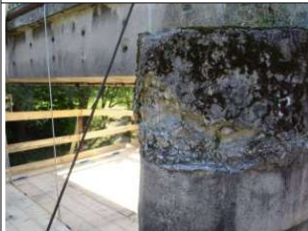
Povodňové zhlaví podpěry P2. Rozpad betonu zhlaví.
