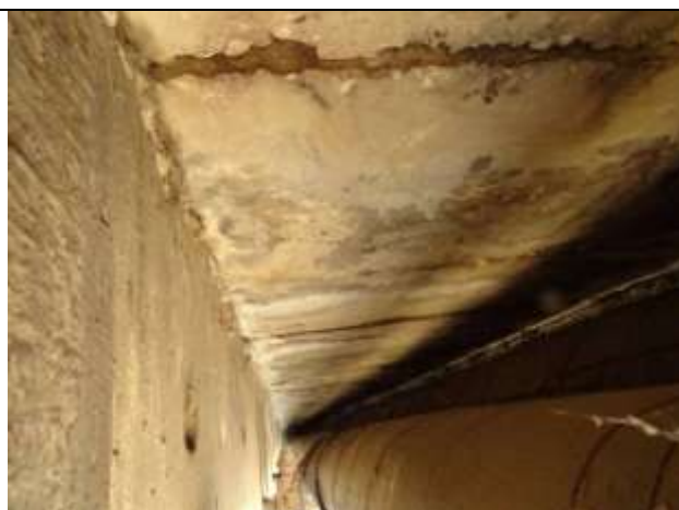
Podhled prefabrikovaných desek mostovky – 2. pole.
