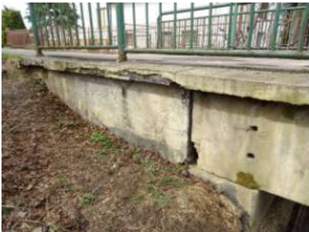
Pravé křídlo opěry 1 – křídlo K1P. Bezložiskové uložení NK.
