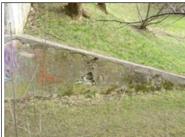
Svahové křídlo před OP4 vpravo. Nesoudržný beton, tvorba kaverny.
