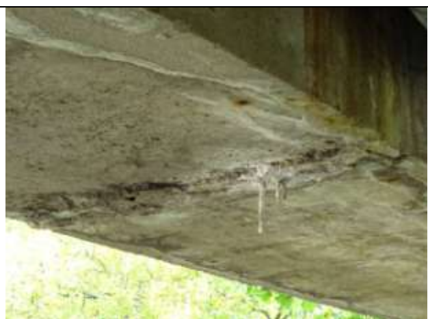
Detail inkrustace ve spáře na podhledu pravého MPD nosníku v poli 2.
