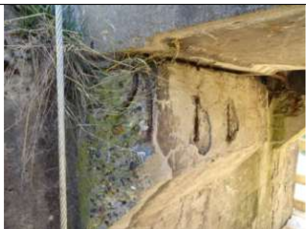
Uložení MPD nosníků na podpěře P2. Rozpad betonu krátké konzoly.
